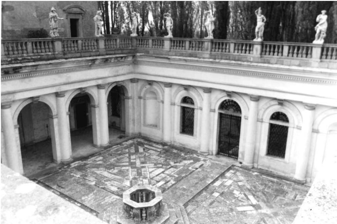
Fig. 11: foto del cortile pensile visto dalla loggia superiore
