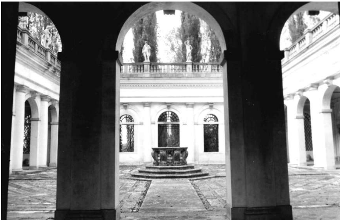
Fig. 12: il cortile pensile visto dall'atrio di ingresso sud alla villa
