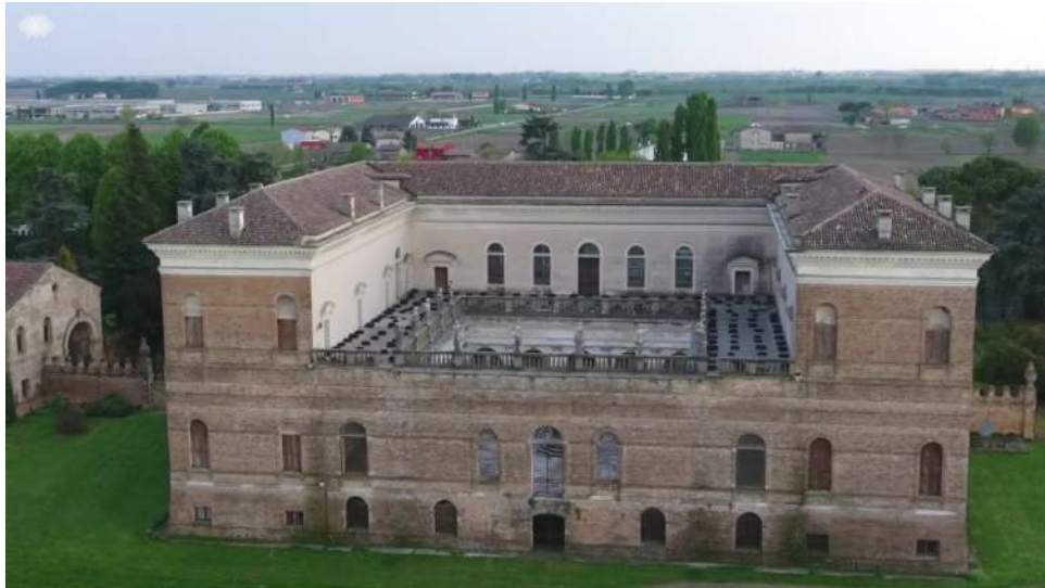
fig. 2a - retro (prospetto nord) di villa Garzoni
